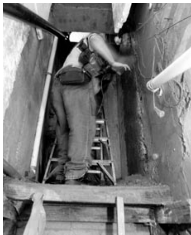
Desde el interior de un baño y con un sistema hidráulico se introducían al narcotúnel, que no había sido concluido.
