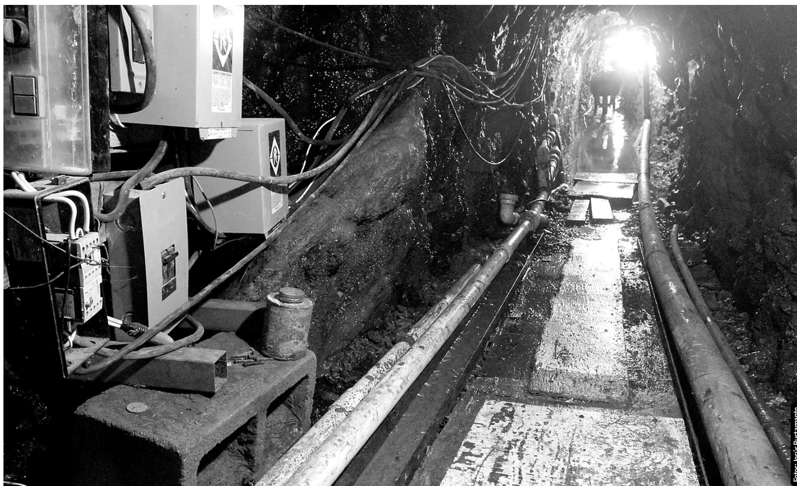
Con una longitud de 135 metros y 1.6 metros de alto, este "narcotúnel" contaba con iluminación y bombeo de agua.
