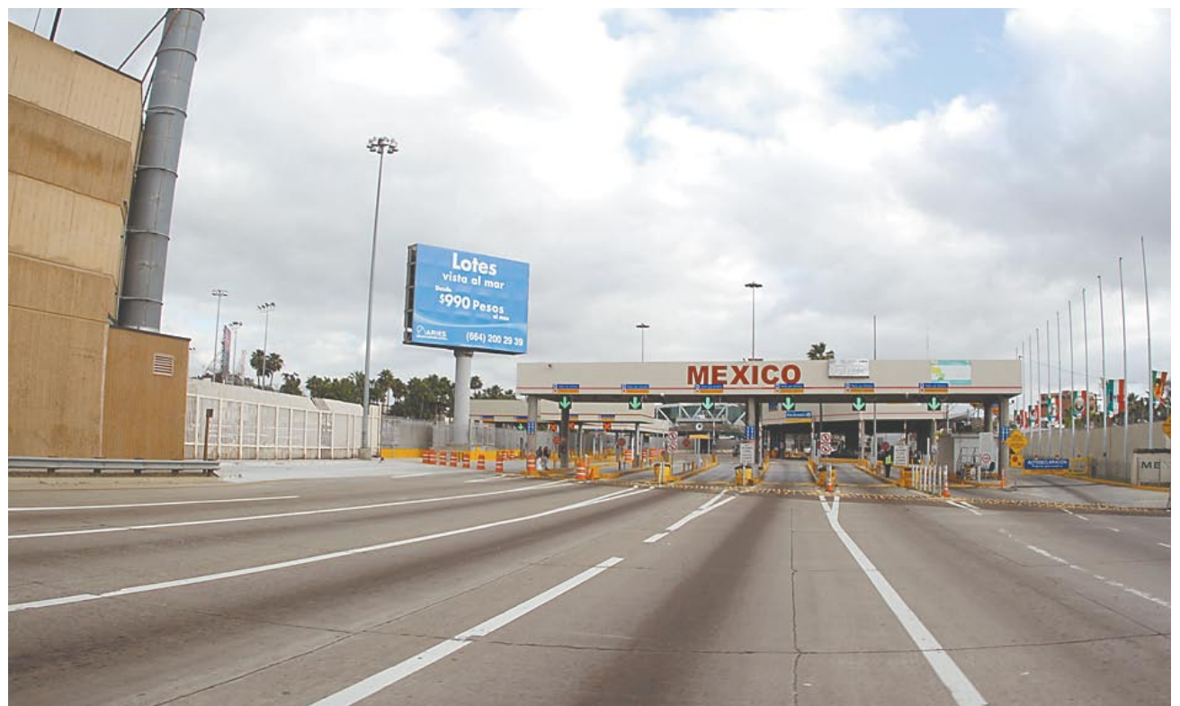
Así luciría de sola la Puerta México durante las reparaciones.
