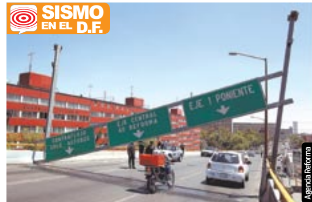
Por la zona de Tlatelolco cayó un letrero sin dañar a nadie.
