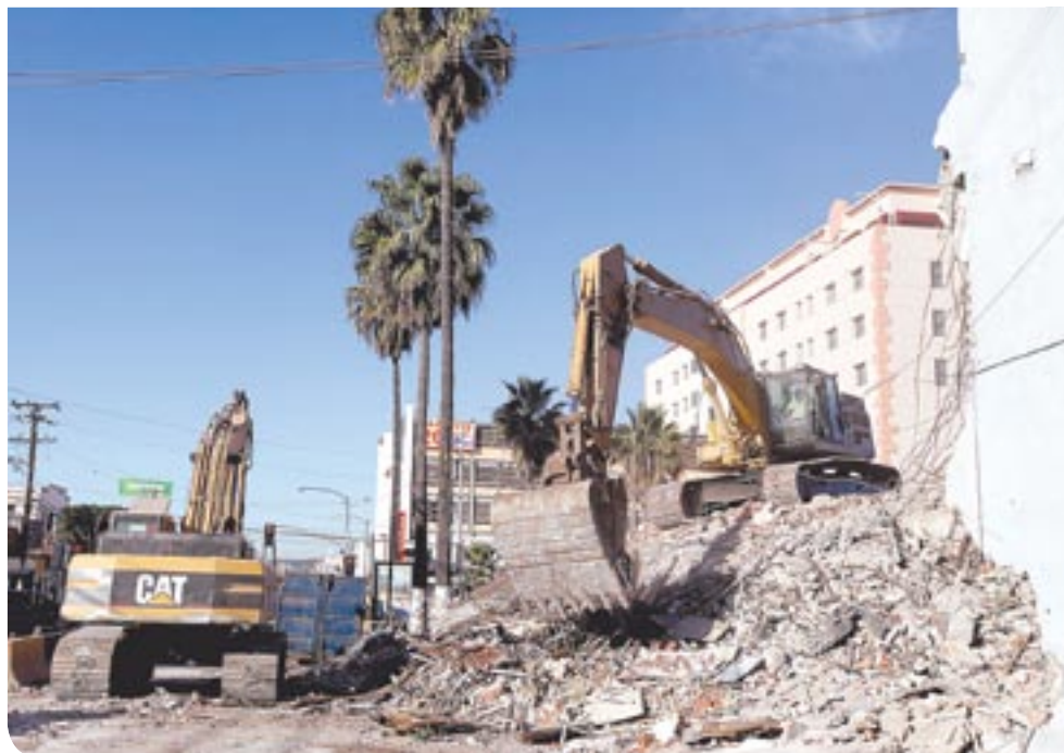
Sigue la demolición, de la comandancia de policía y central de bomberos ubicada en la calle octava
